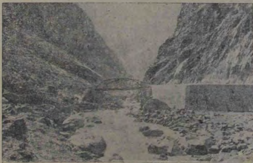
O vedere din Georgia, unde se dau luptele între răzvrătiții Georgieni și bolșevici. Acest pod de fer a fost dărâmat de răzvrătiți.
